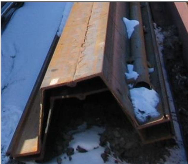
Figure 31: Sealing (Arcoseal) project Bjørvikatunnel – Havneleret.
